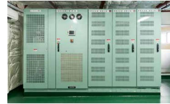
▲蓄電システムにより、作業中の余剰電力を蓄電することができ、電力アシストや停泊中電力として省エネ化を実現。船内電力・消費燃料を見る化し遠隔にて管理が可能。電動スラスターは、新方式<sup>®</sup>を採用し発電機容量を省エネ・騒音減少・排ガス抑制を実現。
